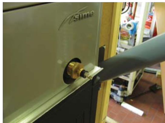
Рис. 28 Предохранительный термостат
