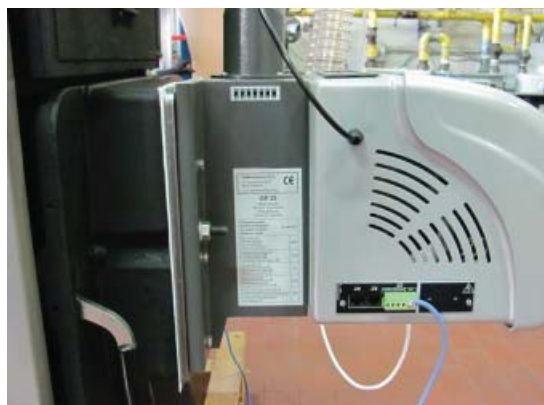
Рис. 26 Крепеж горелки
